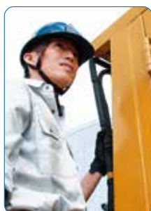
クレーン作業
