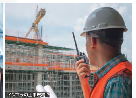
インフラの工事現場に
